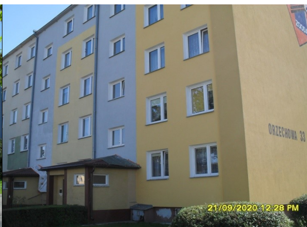
Orzechowa 33- w trakcie remontu
